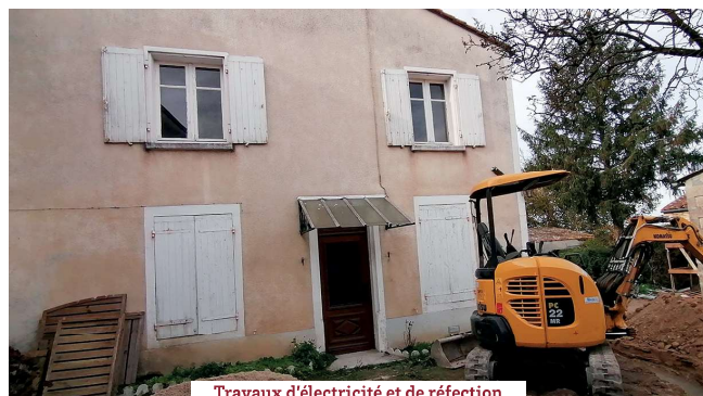
Travaux d'électricité et de réfection
