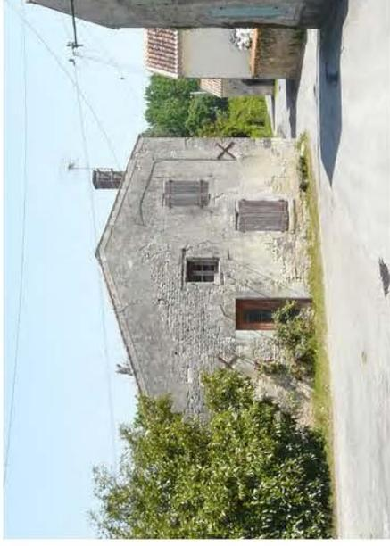
débord de toiture d'environ un rang de tuiles, joint au mur par une corniche simple, peu saillante, pannes non visibles;
